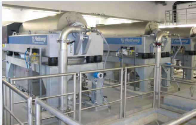
Z5E Decanter in einer deutschen Kläranlage
