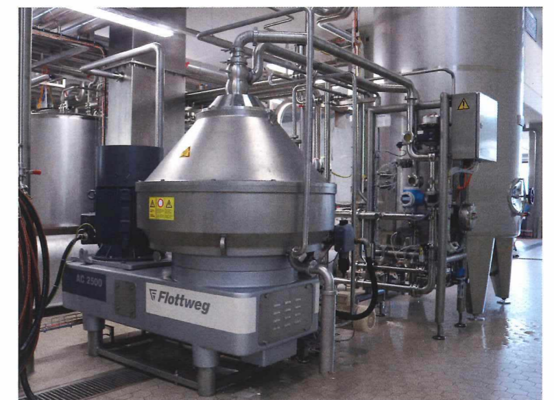
Der Flottweg Separator zur Klärung von Fruchtsäften.
