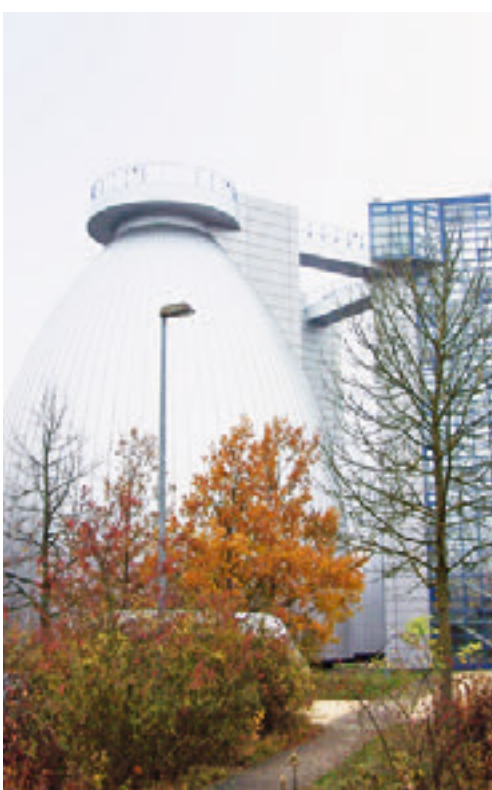
Abb. 2 Faulturm der Kläranlage Landshut.
