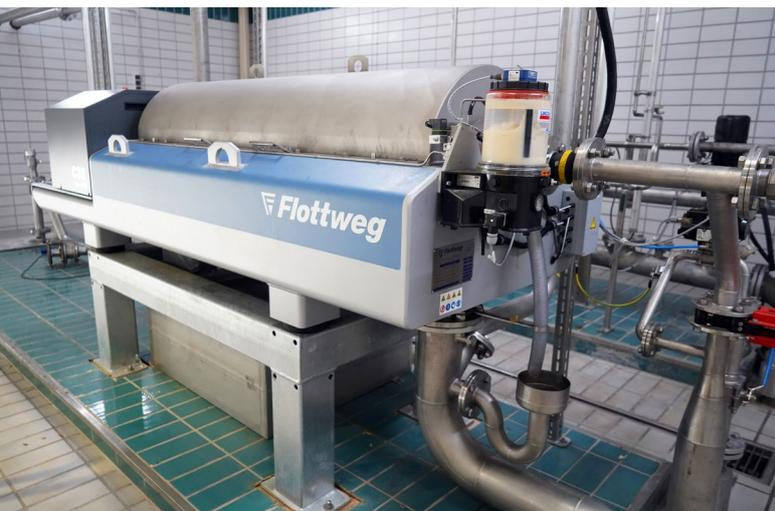
tado un contenido en sólidos y un tiempo de digestión constantes en el digestor. Mediante la centrífuga Flottweg, el contenido de materia seca del exceso de lodo se concentró hasta el 6-7 %, mejorando a su vez el rendimiento del gas. Más biogás implica que en la planta de cogeneración de la Asociación de Aguas Residuales se genere aún más electricidad y calor, lo que hace que la planta de tratamiento sea completamente autosuficiente en cuanto a energía.
