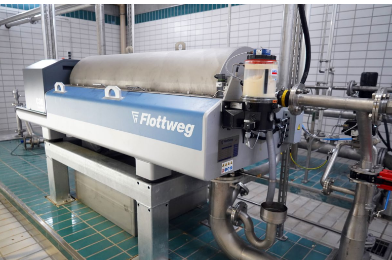
Dekanter C3E OSE służy do zagęszczania nadmiaru osadu.
