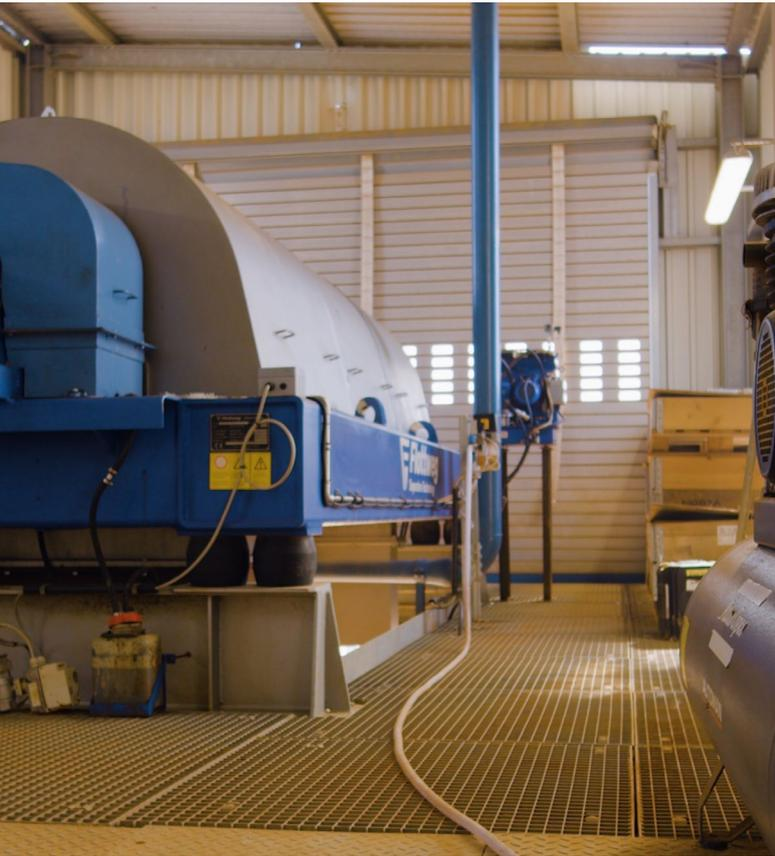
La centrifuga decantadora Z92 de Flottweg procesa hasta 15 toneladas de material por hora.
