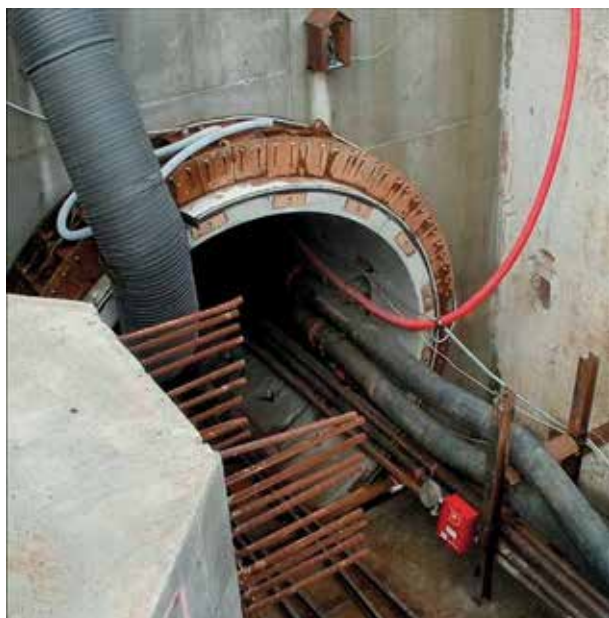
Пример прокладки туннеля с использованием декантера Flottweg
