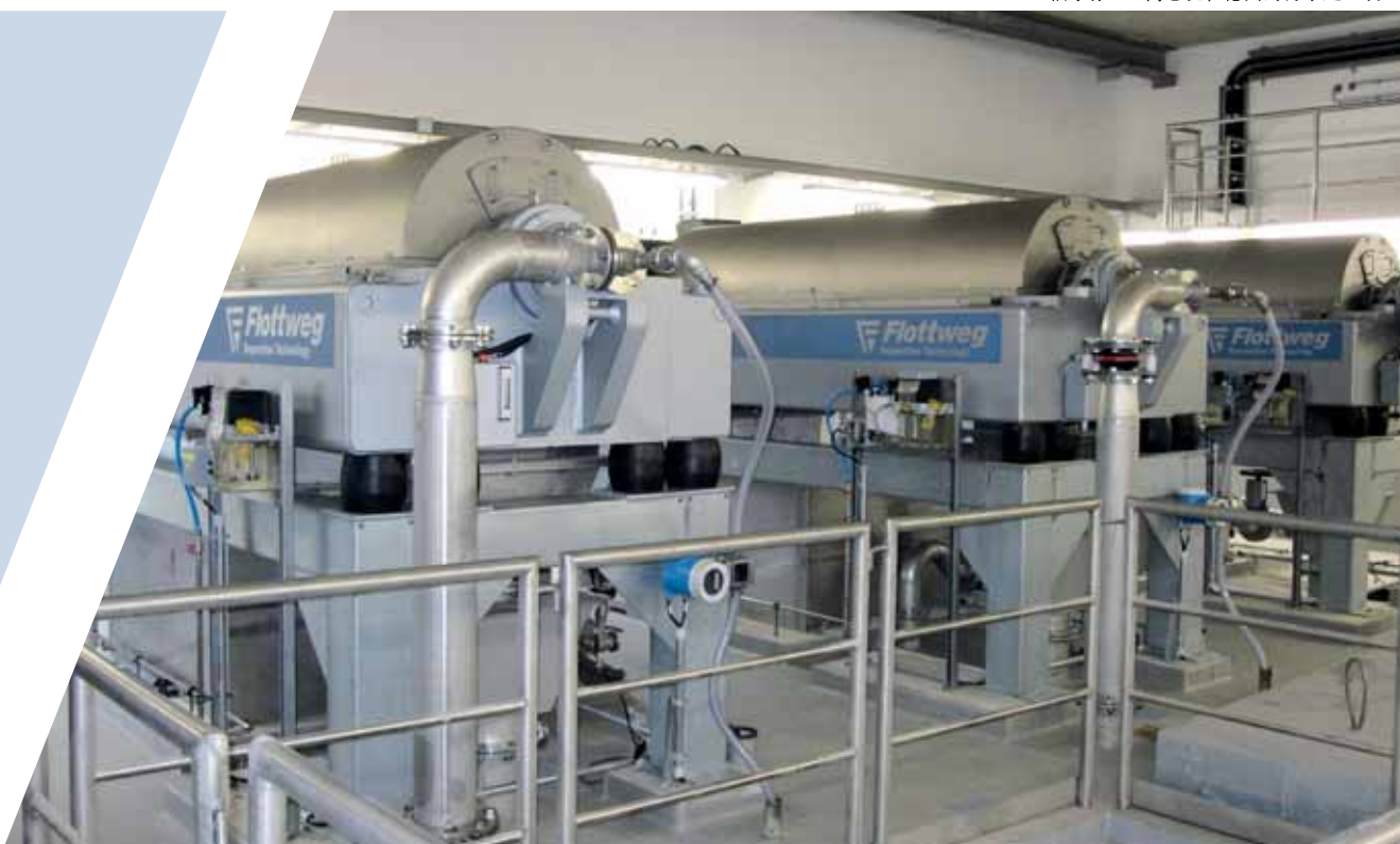
福乐伟Z6E离心机在德国的污水处理装置
