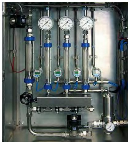
Контрольно-распределительная система Flottweg для подачи инертного газа
