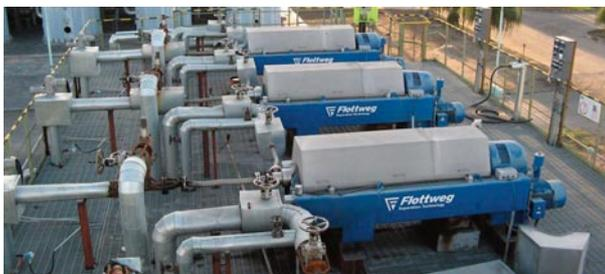
Máquinas Flottweg para el uso en aplicaciones con altas temperaturas
