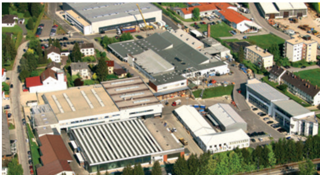
Головной офис FLOTTWEG в Филсбюрге к северо-востоку от Мюнхена.
